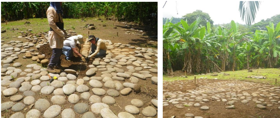
Fig.54. Vistas de proceso de restauración parcial de la Estructura 1.
