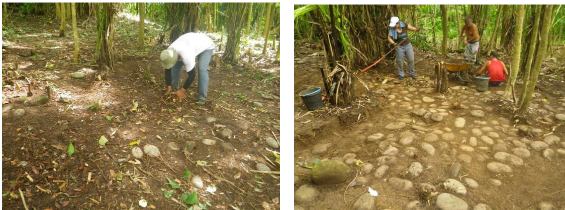
Fig.50. Limpieza de Estructuras 7 y 9 cubiertas por detritos y vegetación.
