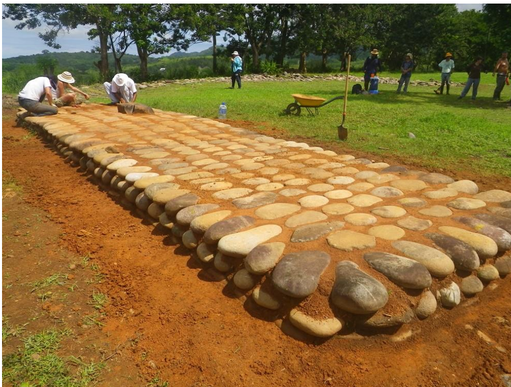
Fig.42. Finalización del proceso de restauración de Estructura 1, sitio Batambal.
